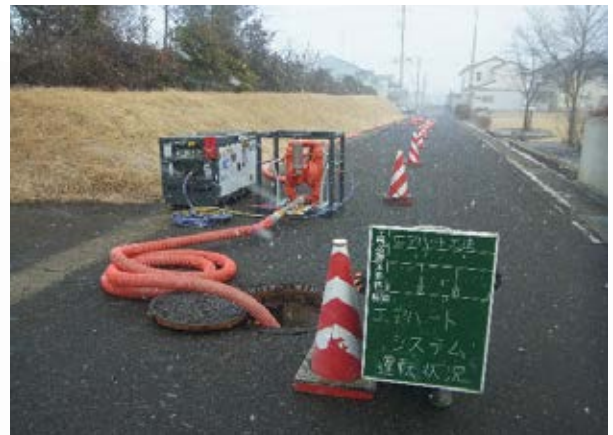
水替工の様子 (最短作業エリア) 交通規制を最小限にすることが可能
