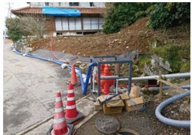
震災復旧 (鳥取県北栄町)
