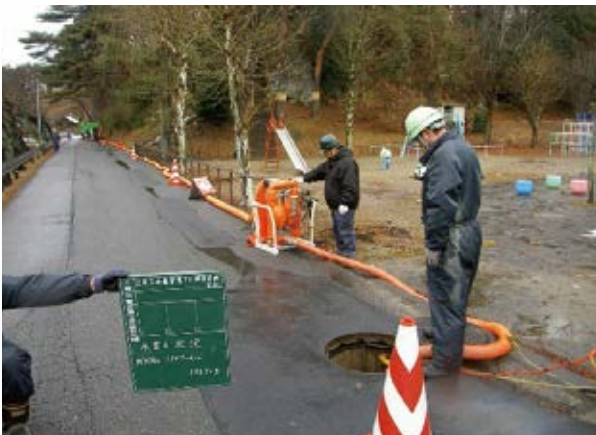
水替工の様子 (最長作業エリア) 現場に応じて、最大300mまで水替え可能
