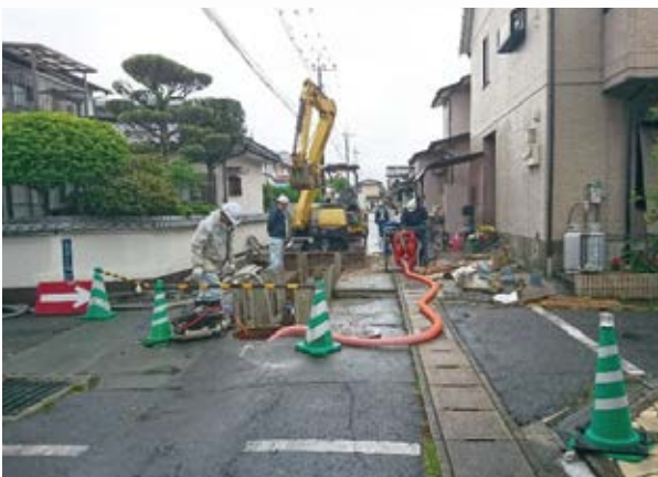
震災復旧 (熊本県熊本市)
