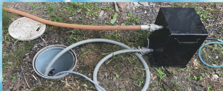
施工イメージ(専用BOX使用) ※排水量 0.18m 3 /min
