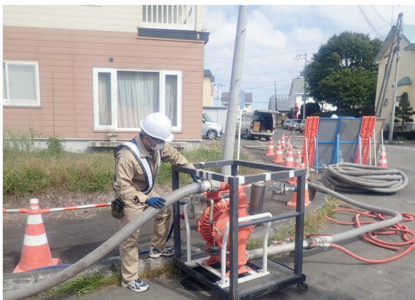
北海道 災害復旧使用状況 (宅柵用ジャンクション使用)
