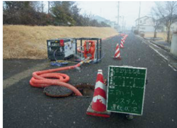
水替工の様子(最短作業エリア) 交通規制を最小限にすることが可能
